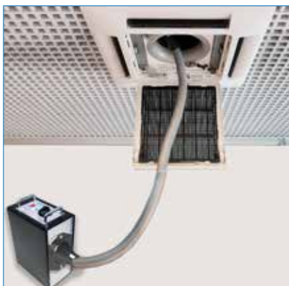
Sanificazione Impianti di climatizzazione e cavedi
